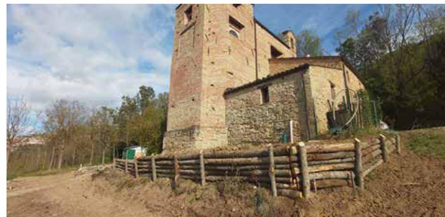
Nel corso dell'intervento sono stati realizzati terrazzamenti tali da consentire ai pellegrini di poter sostare. Con i lavori di riprofilazione sono state realizzate le piazzole in piano, estese in modo poco significativo tanto da non creare uno stravolgimento della configurazione del sito, ma renderlo più agevole e armonizzarlo con il contesto. L'opera è stata eseguita mediante splateamento di tratti mezzacosta, posizionamento di
